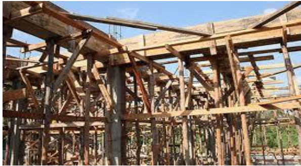
รูปที่ 10.3 แสดงลักษณะการใช้ไม้แบบในโครงสร้าง ที่มา : http://www.bloggang.com,2558
