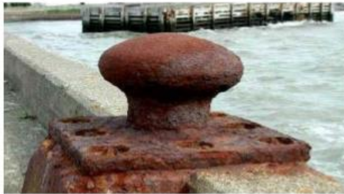
รูปที่ 12.2 แสดงลักษณะการกัดกร่อนแบบสม่ำเสมอ
