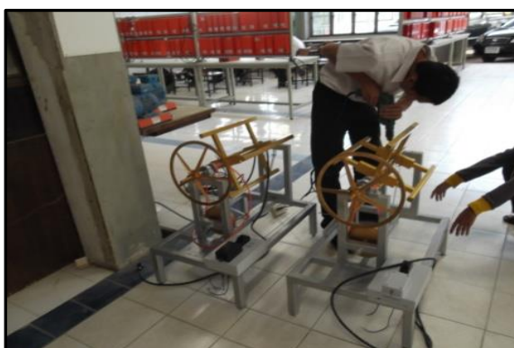
ภาพที่ 3-14 แสดง การติดตั้งชุดรองรับส่วนหมุนที่แกนเพลลาเครื่อง
