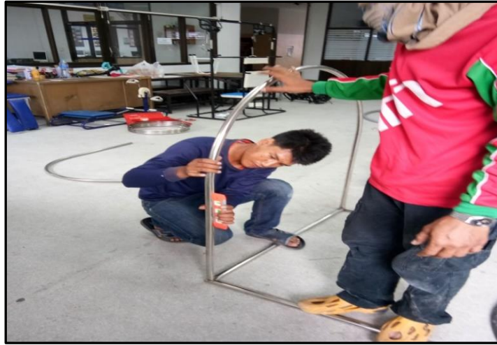
ภาพที่ 3-15 แสดง การวัดระดับน้ำเพื่อจัดทำโครงสร้างเครื่อง ให้ได้ระดับ
