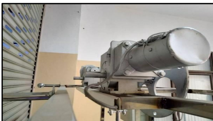
ภาพที่ 3-141 แสดงการทดสอบชุดเพลาส่งกำลังเข้ากับมอเตอร์เกียร์ขนาดแรงดันไฟฟ้า 24 โวลต์ (ที่มา : วทีญญ บุตรศรี, 2562)
