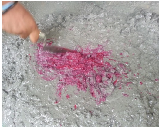
ภาพที่ 7.37 ผสมปูนซีเมนต์ หิน ทราย สีฝุ่น และน้ำ ที่มา : สุรศักดิ์ เทพทอง, 2557
