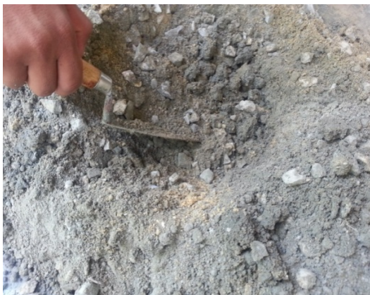
ภาพที่ 7.37 ผสมปูนซีเมนต์ หิน ทราย สีฝุ่น และน้ำ ที่มา : สุรศักดิ์ เทพทอง, 2557
