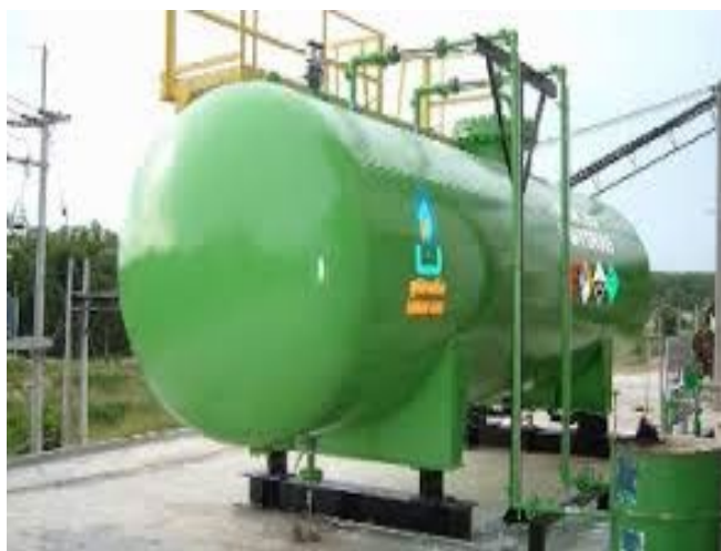
ภาพที่ 1.5 ถังแรงดันสูงสำหรับบรรจุแอมโมเนีย ที่มา : สุรศักดิ์ เทพทอง, 2557
