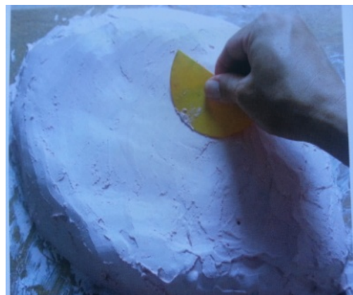
ภาพที่ 4.8 แปรงทาปูนปลาสเตอร์และเกลี่ยให้มีความหนาเท่า ๆ กัน ที่มา : สุรศักดิ์ เทพทอง, 2557
