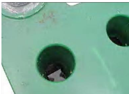
รูปที่ 4.21 การตรวจสอบการมัวหมองของน้ำยาแบตเตอรี่
