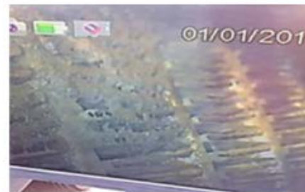
รูปที่ 9 ตรวจสอบสภาพชุดคอยล์เย็นก่อนทำการล้างทำความสะอาดด้วยกล้อง Snake Scope
