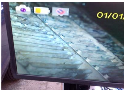
ภาพที่ ค.22 ตรวจสอบชุดคอยล์เย็นหลังทำการล้างทำความสะอาดด้วยกล้อง Snake Scope
