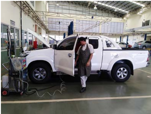
ภาพที่ 2.13 การล้างตู้แอร์รถยนต์แบบไม่ถอดตู้ (ที่มา : ชินภัทร แก้วโกมินทวงษ์. 2560)
