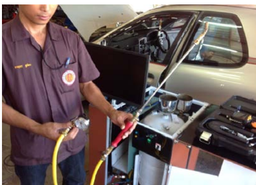
ภาพที่ ข.14 ประกอบสายยางฉีดล้างชุดคอยล์เย็นเข้ากับเกจวัดควบคุมแรงดันต่ำ
