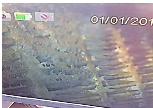
ภาพที่ ค.17 ตรวจสอบสภาพชุดคอยล์เย็นด้วยกล้อง Snake Scope ก่อนทำการล้าง
