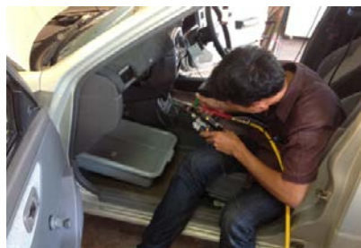
ภาพที่ 3.25 ใช้หัวฉีดน้ำแรงดันต่ำฉีดน้ำล้างทำความสะอาดชุดคอยล์เย็นและใช้กล้อง Snake Scope ตรวจสอบอีกครั้งผ่านจอมอนิเตอร์
