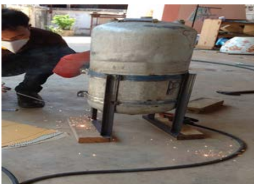
ภาพที่ ก.5 เชื่อมฐานจับยึดถังบรรจุน้ำและ ถังบรรจุน้ำยา
