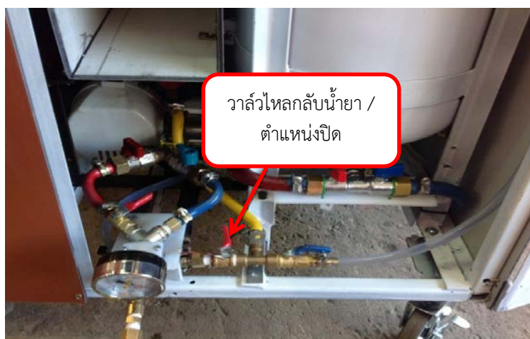
ภาพที่ ข.31 ปิดวาล์วไหลกลับสีแดงของน้ำยาทำความสะอาดชุดคอยล์เย็น
