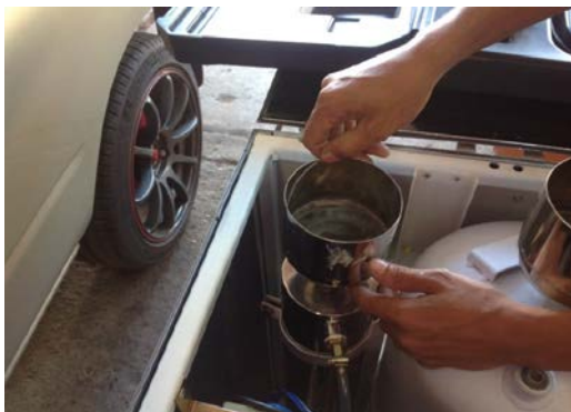
ภาพที่ ข.6 ติดตั้งกรวยเติมน้ำยาเข้ากับถังบรรจุน้ำยาล้างทำความสะอาดชุดคอยล์เย็น
