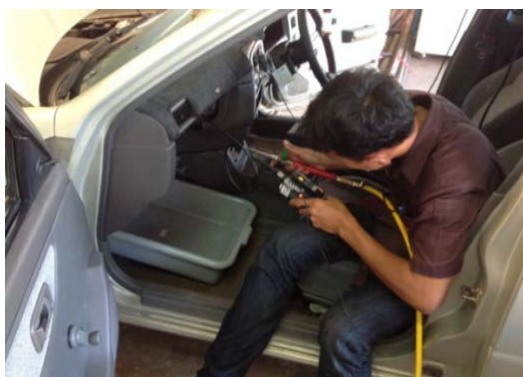
ภาพที่ ข.33 ใช้หัวฉีดน้ำแรงดันต่ำฉีดน้ำล้างทำความสะอาดชุดคอยล์เย็นและใช้กล้อง Snake Scope ตรวจสอบอีกครั้งผ่านจอมอนิเตอร์
