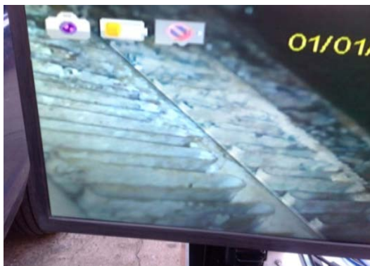
ภาพที่ ข.34 ใช้กล้อง Snake Scope ตรวจสอบความสะอาดชุดคอยล์เย็นอีกครั้งผ่านจอมอนิเตอร์ ก่อนทำการประกอบอุปกรณ์กลับเข้าที่เดิม
