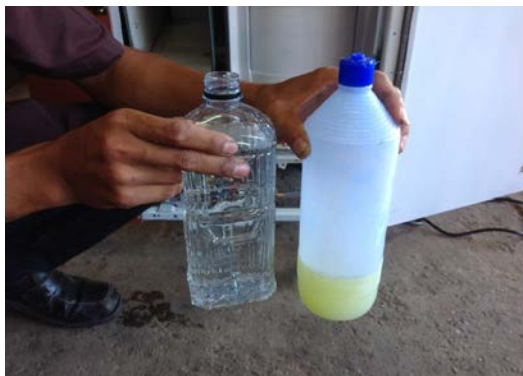
ภาพที่ ข.9 ทำการผสมน้ำกับน้ำยาล้างทำความสะอาดชุดคอยล์เย็นอัตราส่วน 2:1 คือ น้ำ 2 ส่วน และน้ำยาล้างทำความสะอาดชุดคอยล์เย็น 1 ส่วน
