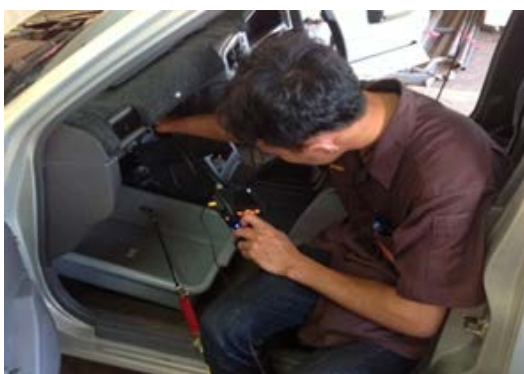
ภาพที่ ข.24 ตรวจสอบชุดคอยล์เย็นด้วยกล้อง Snake Scope ก่อนทำการล้าง
