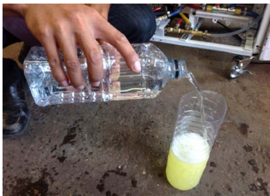
ภาพที่ ข.10 เทน้ำเปล่าลงไปผสมกับน้ำยาล้างทำความสะอาดชุดคอยล์เย็นในอัตราส่วนที่ตรงไว้ คือ 2:1 น้ำ 2 ส่วน และน้ำยาล้างทำความสะอาดชุดคอยล์เย็น 1 ส่วน
