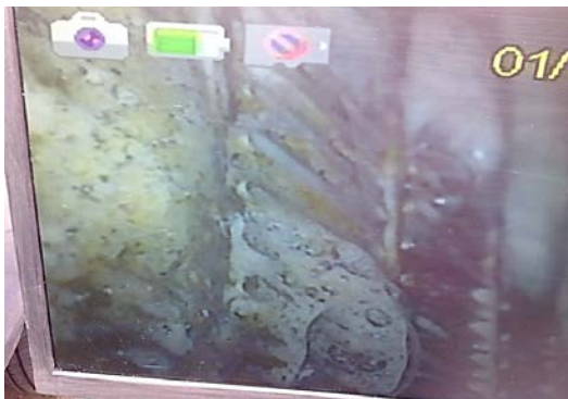
ภาพที่ ค.20 เมื่อล้างทำความสะอาดชุดคอยล์เย็นด้วยน้ำยาแล้วปล่อยทิ้งไว้ 3-5 นาที
