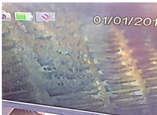
ภาพที่ ข.25 ตรวจสอบชุดคอยล์เย็นก่อนทำการล้างด้วยกล้อง Snake Scope
