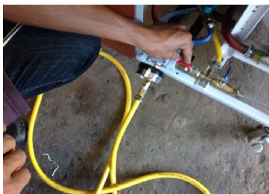
ภาพที่ ข.18 เปิดวาล์วน้ำยาทางด้านไหลกลับให้อยู่ในตำแหน่งเปิด
