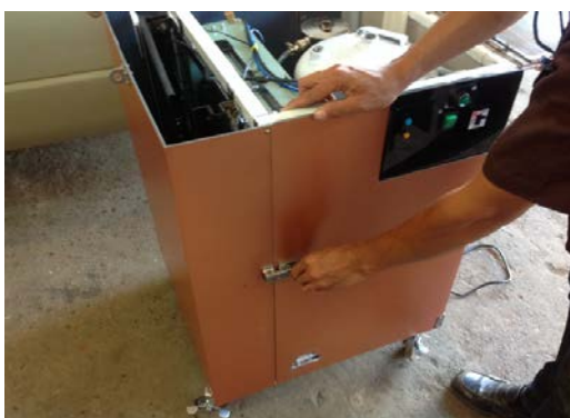
ภาพที่ ข.2 ปิดฝาด้านหน้าออกเพื่อทำการต่อสายยางฉีดล้างทำความสะอาดชุดคอยล์เย็น
