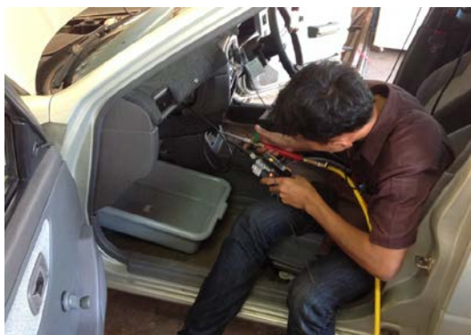
ภาพที่ ค.21 ใช้น้ำฉีดล้างทำความสะอาดชุดคอยล์เย็นอีกครั้ง
