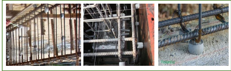
(ข) ตัวอย่างระยะคอนกรีตหุ้มเหล็กเสริมและการทวนลูกปูนในแบบหล่อ
