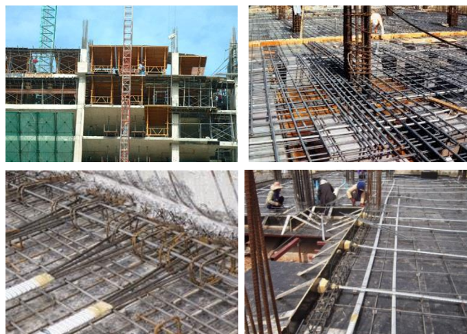
รูปที่ 3.32 การติดตั้งเสริมเหล็กแผ่นพื้นไร้คาน POST TENSION SLAB
