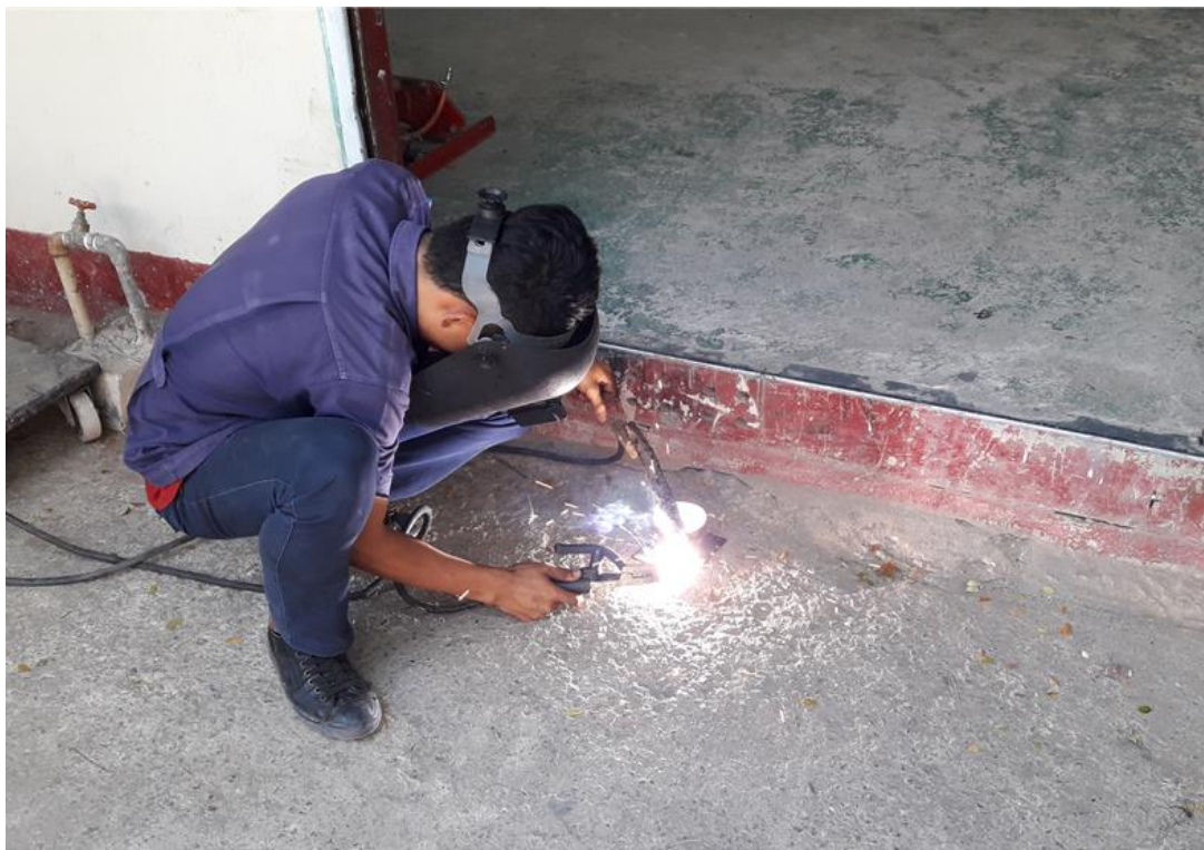
ภาพที่ 3-23 เชื่อมกระบอกสูบเป็นชิ้นส่วนฝักบัว
