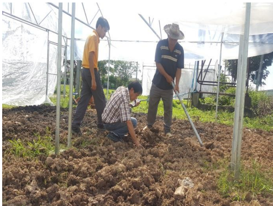
การขุดดินนำไปตรวจสอบสภาพดิน
