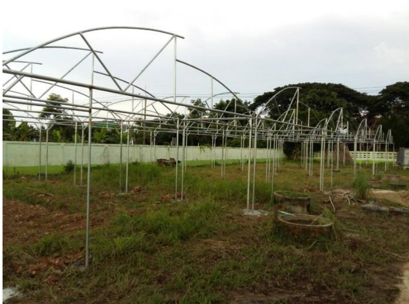
การขึ้นโครงสร้างโรงเรือนปลูกผักออแกนิก
