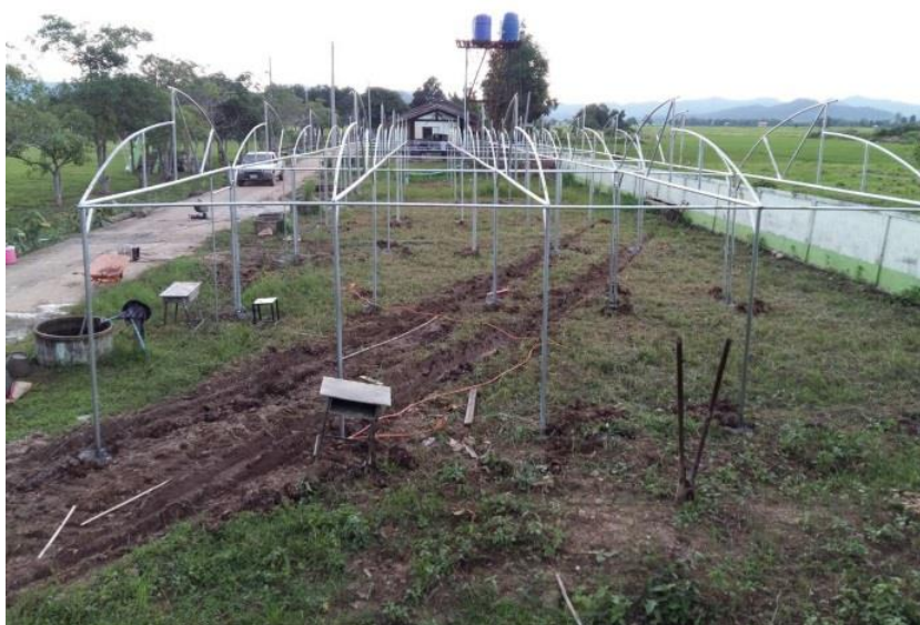
การสร้างโครงสร้างโรงเรือนปลูกผักออแกนิก
