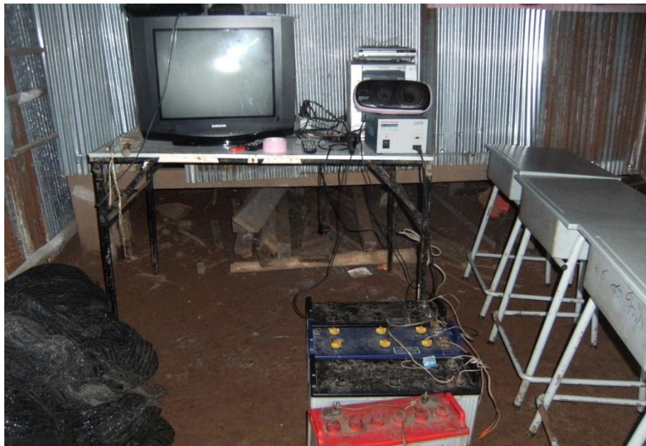
ภาพแสดงเครื่องเล่นโทรทัศน์และระบบไฟฟ้าที่ใช้แบตเตอรี่จากระบบโซลาร์เซลล์ เพื่อใช้ในกิจกรรมการเรียนการสอน
