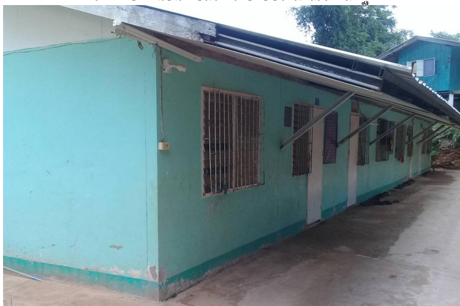
ภาพหอพักนอน ก่อสร้างโดยงบประมาณจากสพฐ.
