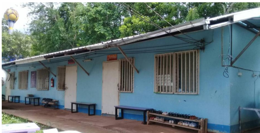
ภาพหอพักนอน ก่อสร้างโดยงบประมาณจากสพฐ.
