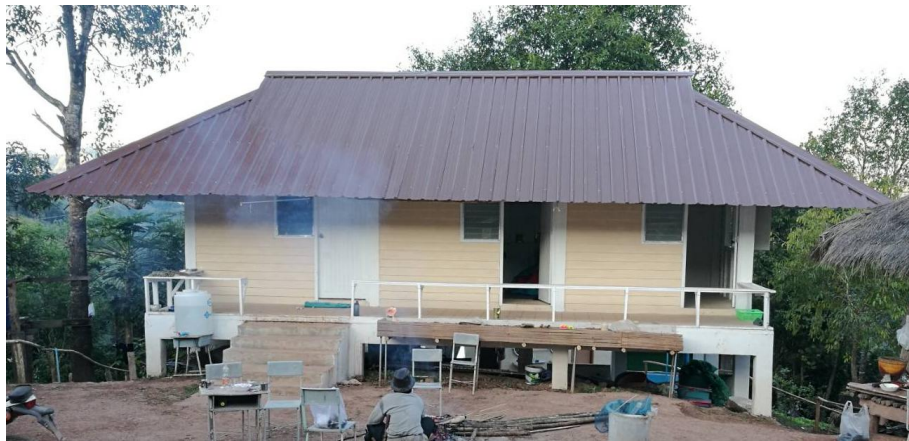
ภาพแสดงอาคารบ้านพักครู งบประมาณโดยการรับบริจาค
