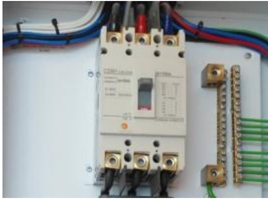
รูปที่ 1.9 การต่อสายเข้าอุปกรณ์ไฟฟ้า 8
