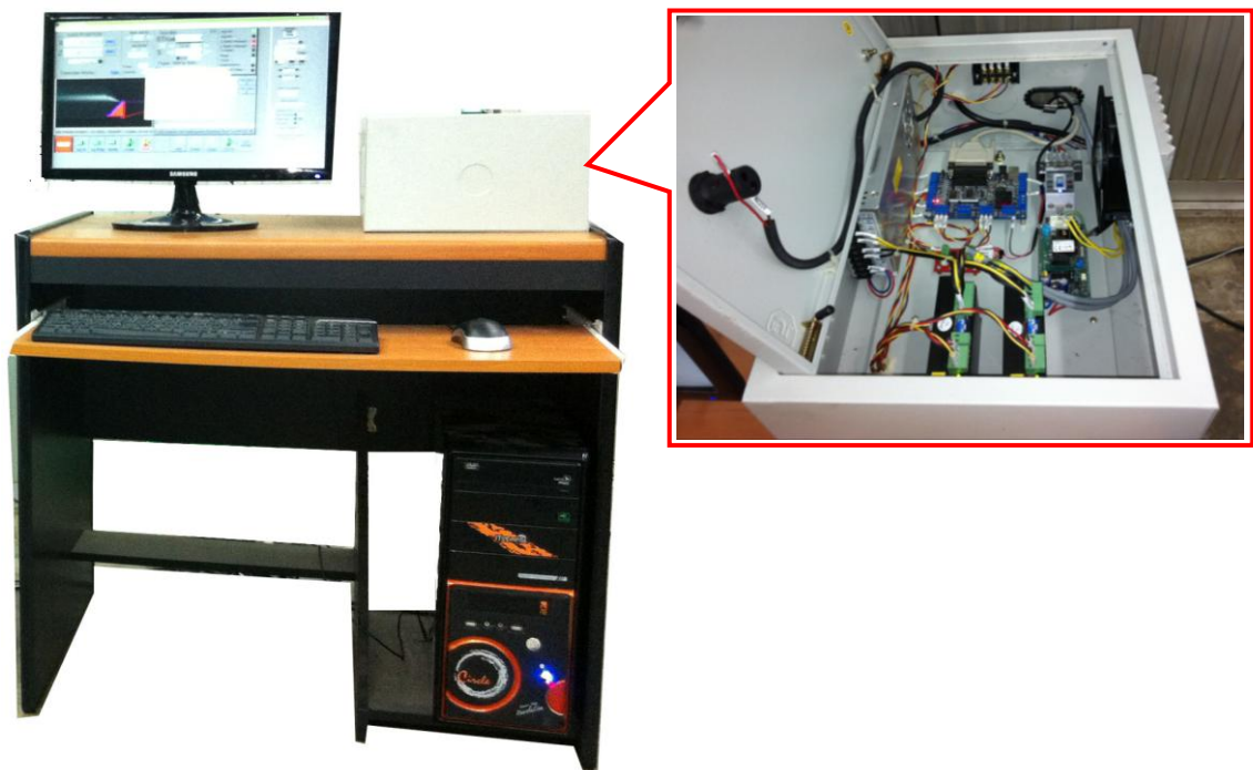
ภาพที่ 3-7 แสดงชุดควบคุมถูกติดตั้งเรียบร้อยแล้ว
