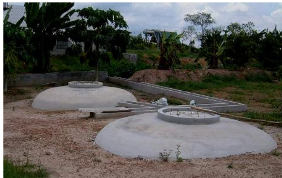
ภาพที่ 11.8 บ่อก๊าซชีวภาพในฟาร์มสุกรขนาดเล็กและขนาดกลาง ที่มา : ไพฑูรย์ (2553)
