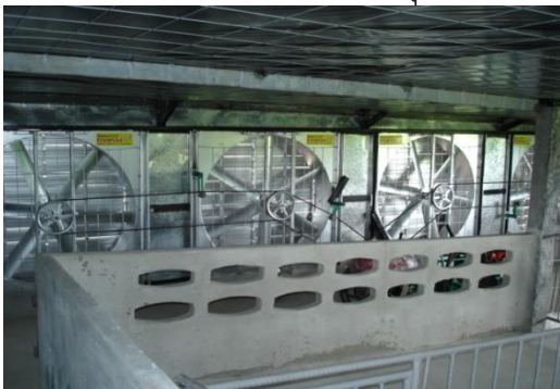
การติดตั้งพัดลมดูดอากาศออกด้านหลังโรงเรียน และติดตั้งเครื่องยนต์ดีเซลไว้กรณีไฟฟ้าดับ
