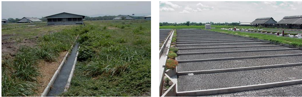
ภาพที่ 3.6 ระบบบำบัดน้ำเสีย และลานตากมูลสุกร ที่มา : ไพฑูรย์ (2557)
